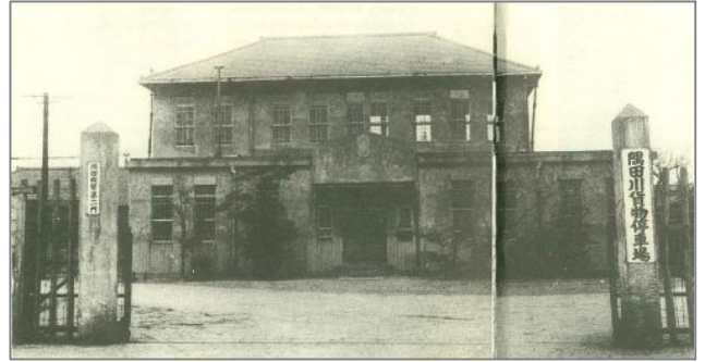
捕虜収容場に使用された隅田川貨物駅
