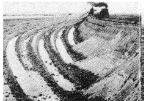
畑の土を引き揚げ、22 キロを 汽車で護岸に変えていく作業
