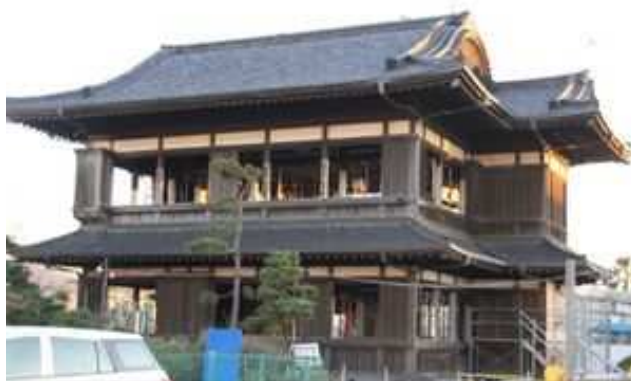
移築の為解体中の「喜翁閣」
